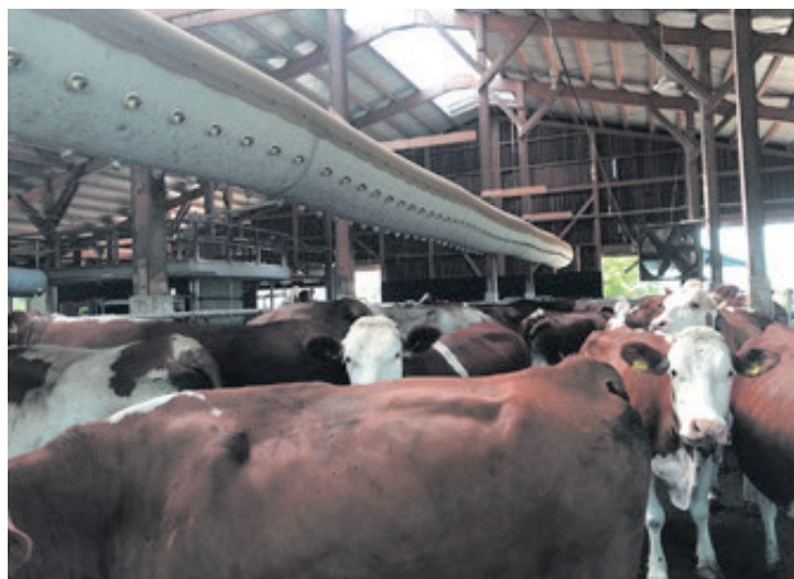
Schlauchkühlungen haben nicht selten zu geringe Windgeschwindigkeiten auf der Kuh, um wirklich eine Kühlwirkung zu haben. BRH
