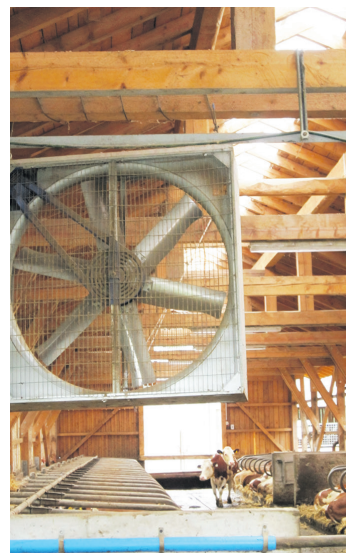
Ventilatoren müssen gut überlegt platziert werden. Manche Fabrikate haben sehr geringe Wurfweiten. BRH
