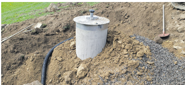
Schachtquelle mit deutlich sichtbarer Fangdränage.
