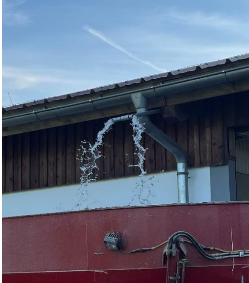
Die Wasserzugabe muss praktisch und schnell erfolgen – Bsp. Abbildung: 1 Zoll Zuleitung von altem Milchtank weg aufgeteilt auf 2 Auslassöffnungen
