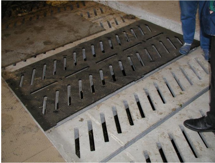
Abbildung 5: Spalten mit Gummiauflage.
