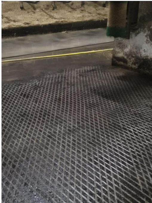
Abbildung 3: Ergebnis Fräsen / Rillieren .
