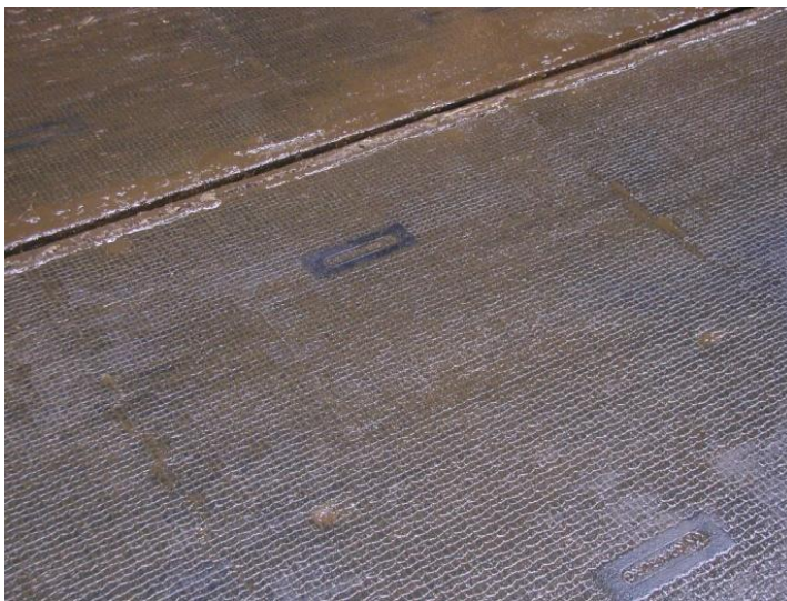
Abbildung 6: Planbefestigter Boden mit Gummiauflage.
