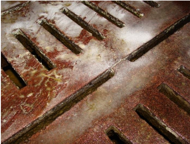
Abbildung 2: Nach dem Auftragen beginnt die Zitronensäure zu schäumen.
