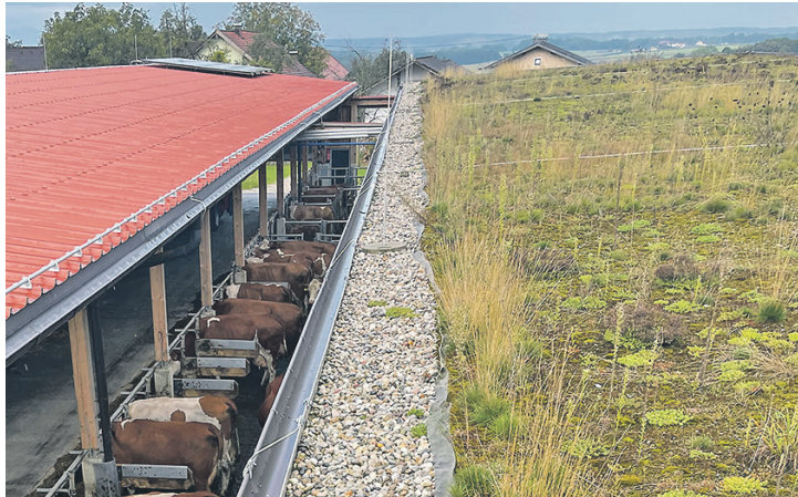
Das Dach wirkt als ökologische Ausgleichsfläche.
