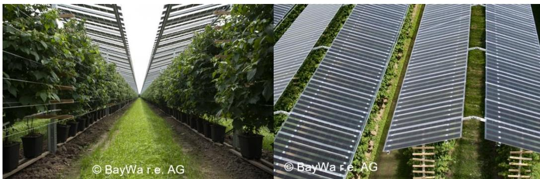
**3. Flächen mit unterfahrbaren Modulen**, die so hoch (mind. 4,5 m Höhe, Unterkante, bei nachgeführten, d.h. dem Sonnenstand folgenden Systemen die Horizontalstellung) montiert sind, dass die gesamte darunterliegende Fläche weiterhin für in der Landwirtschaft verwendete Fahrzeuge gefahrlos benutzbar und auf diese Weise für land- und forstwirtschaftliche Zwecke nutzbar ist.
