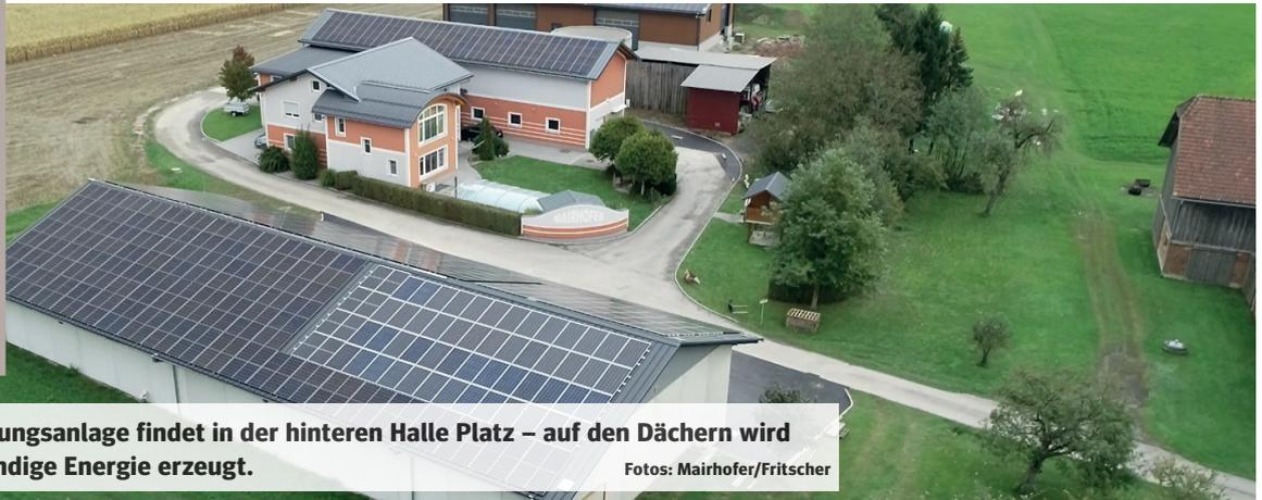
Die kompakte Trocknungsanlage findet in der hinteren Halle Platz – auf den Dächern wird mittels PV die notwendige Energie erzeugt.
