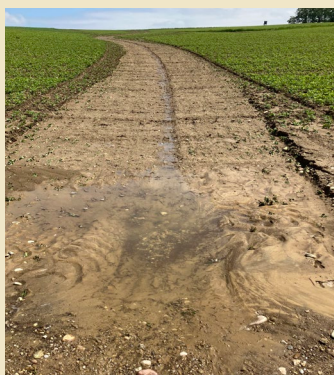
Abb. 3: Der gleiche bevorzugte Abflussweg (siehe Abb. 2) in der Realität nach einem Starkregen im Frühjahr 2024.
