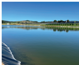
Zentrales Speicherbecken mit 40.000 Kubikmeter Fassungsvermögen. Gerhard Schiefermüller
