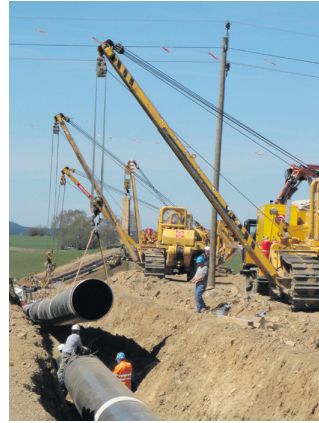
Für die Wiederherstellung der Böden wurde eine bodenkundliche Baubegleitung festgeschrieben.
