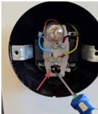
Die Kontaktfeder kann man vorsichtig mit einem Schraubenzieher biegen.
