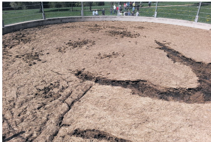
Bereits errichtete offene Güllegruben müssen nicht abgedeckt werden, wenn eine dauerhaft stabile Schwimmdecke vorhanden ist. BWSB/Wallner
