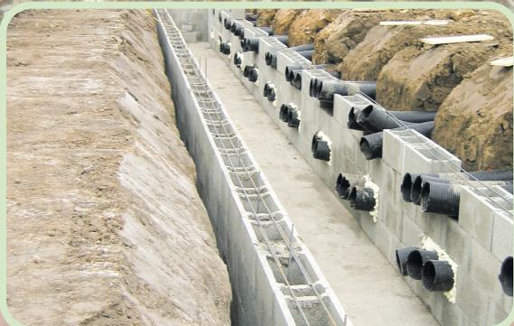
Rohrregisterspeicher wärmen die Zuluft in den Wintermonaten an und kühlen sie in den Sommermonaten.
