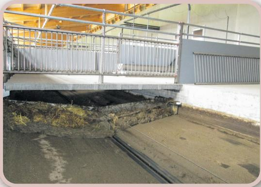
Unterflurschieber mit Harrinne – Ein Quergefälle im Unterflurkanal bewirkt, dass der Harn rasch zur Sammelrinne abläuft. Ein Schieber transportiert den angefallenen Kot in eine geschlossene Grube oder einen Mistlagerplatz.
