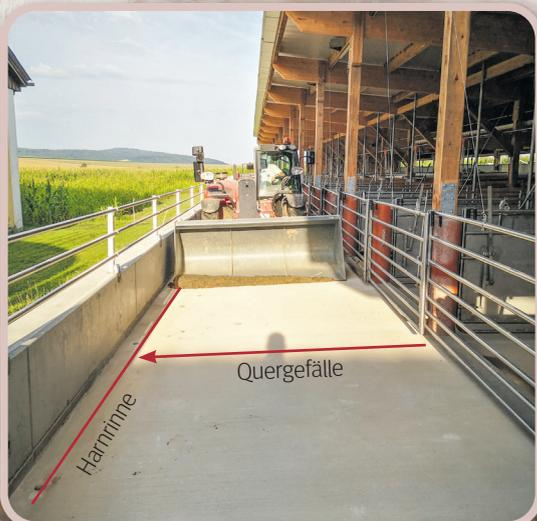
Unüberdachter planbefestigter Auslauf mit Quergefälle und Harrinne. Die anfallenden Regenwässer und der Harn werden über das Quergefälle in eine Sammelrinne abgeleitet.
