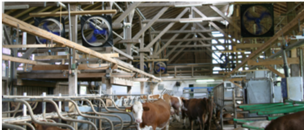
Ventilatorenanordnung im Milchviehstall (LfL Bayern)
