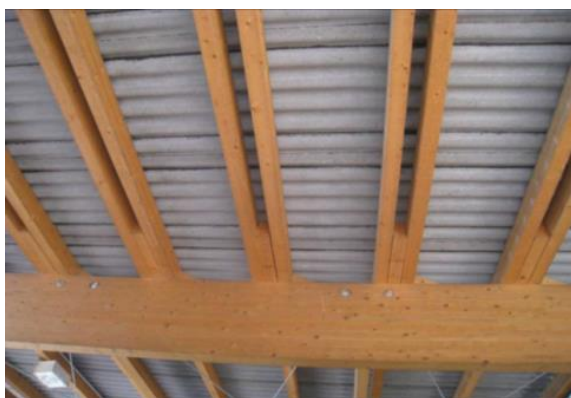
Abb.5: Beim Bau sollten helle, isolierte Dachflächen verwendet werden.
